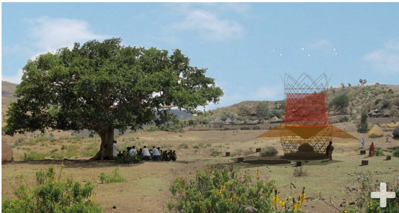
Le "Warka Towers" producono fino a 90 litri di acqua pulita al giorno, convogliando l'umidità naturale presente nell'aria.
